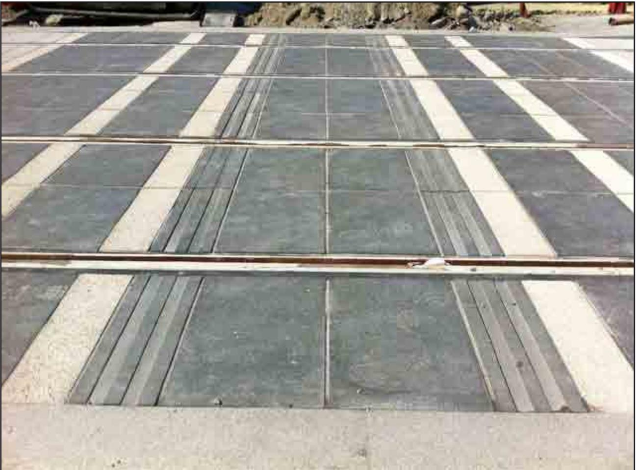
Un dispositif de marquage visuel et tactile a été adopté grâce à des essais auprès d'usagers pour faciliter le repérage de la traversée de la plate-forme du tramway (déploiement prévu pour l'extension de la ligne T3).
